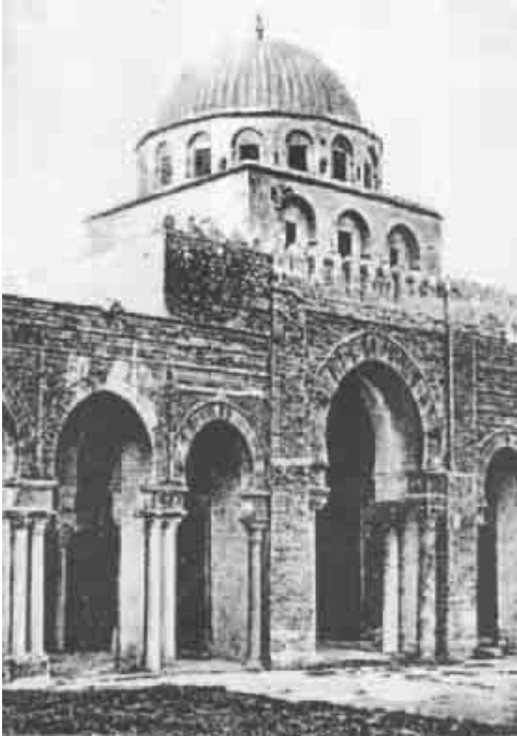
مسجد سيدي عقبة في القيروان . الواجهة وتبدو احدى قبتي المسجد فوقها
