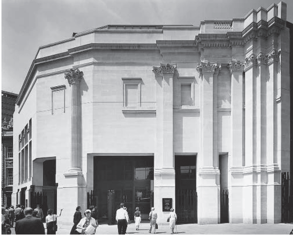
شكل ٤-٨: جناح سينسبري في المعرض الوطني بلندن (١٩٩١)، تصميم فينتوري، مؤسسة سكوت براون أند أسوشيتس. (مبنى جديد، يحاكي أساليب معمارية أقدم. أهى محاكاة ساخرة؟)
