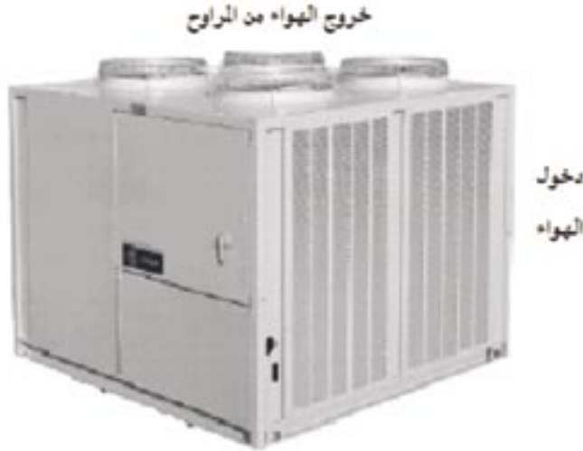
شكل ٥-٢ مكثف مبرد بالهواء
