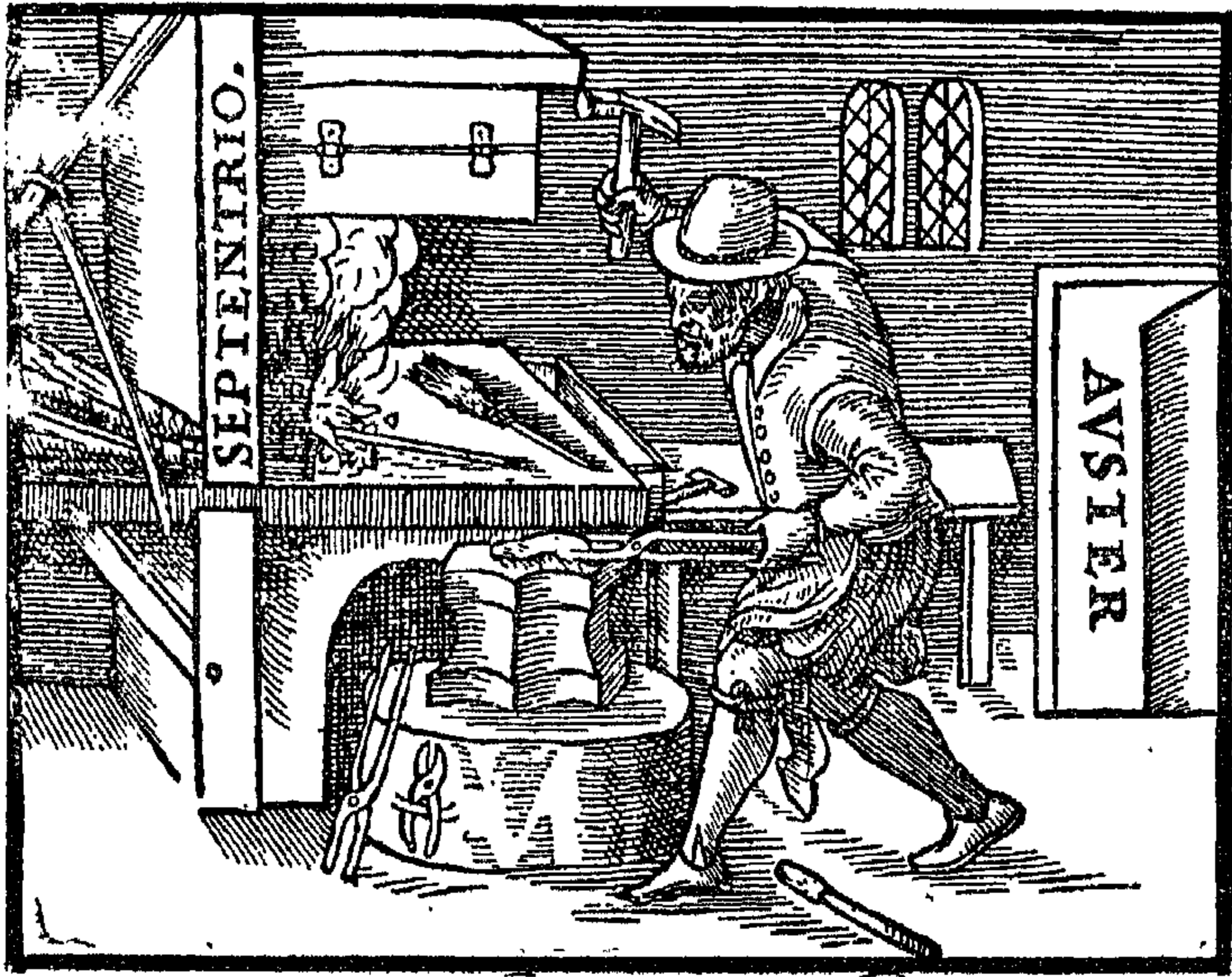
(شكل ١٩) مغطسة ساق من الحديد يطرقتها
