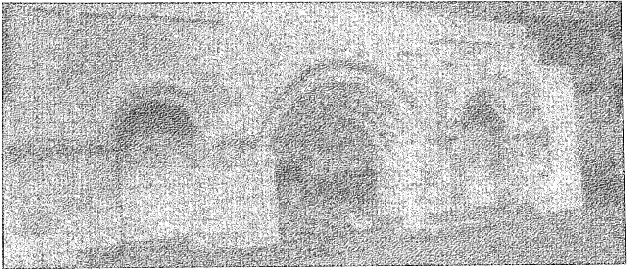
بوابات مصنع الطرابيش قبل وبعد الترميم
