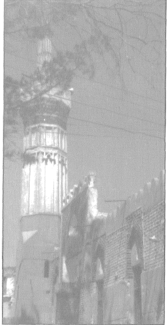
جامع الصعيد قبل الترميم
