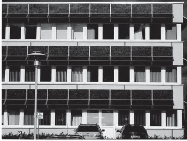
الشكل (10-13): واجهة بمنظومات فولتضوئية كحواجب للنوافذ للتقليل من حمل مكيف الهواء وكزخارف (شوهدت في سولارورلد (Solarworld) في مدينة فريبيرغ، ساكسوني (Saxony)).
