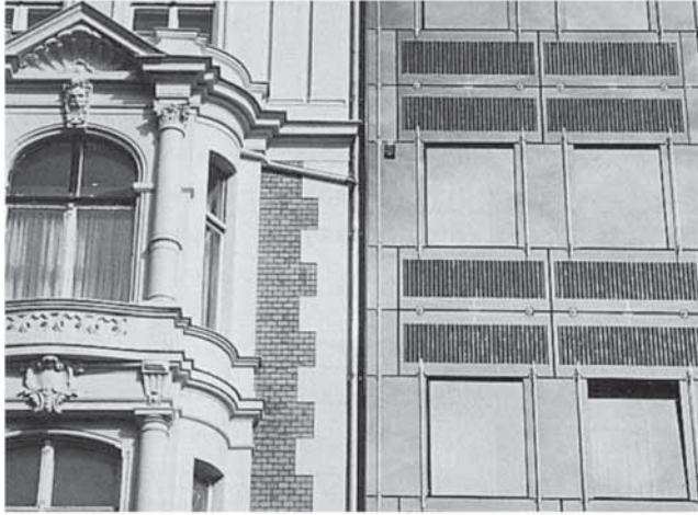
الشكل (12-10): واجهة فولتضوئية في مبنى أوكوتيك (Ökotec) ببرلين - كريوزبرغ (Berlin-Kreuzberg) (الأيمن) مع واجهة تاريخية من متحف جرونديزيت (Gründerzeit)
